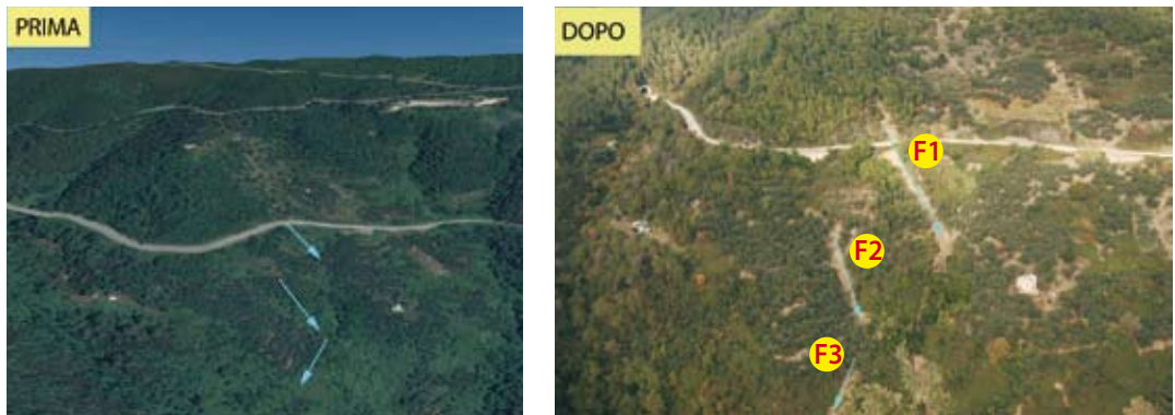
Fig. 4. (In alto a sinistra) Una foto aerea dell'anno 2006. (In alto a destra) La fotografia dello stesso luogo scattata il 2 novembre 2011. Le frane sono avvenute su terrazzamenti abbandonati e coperti dal bosco: f1: bosco misto; f2: terrazzamenti olivati abbandonati; f3: arbusteto/macchia. (Above, left) An aerial photograph of the year 2006. (Right) The corresponding picture taken on 2 November 2011. The landslide occurred on mixed woods (f1), abandoned olive terraces (f2) and shrubland (f3).
